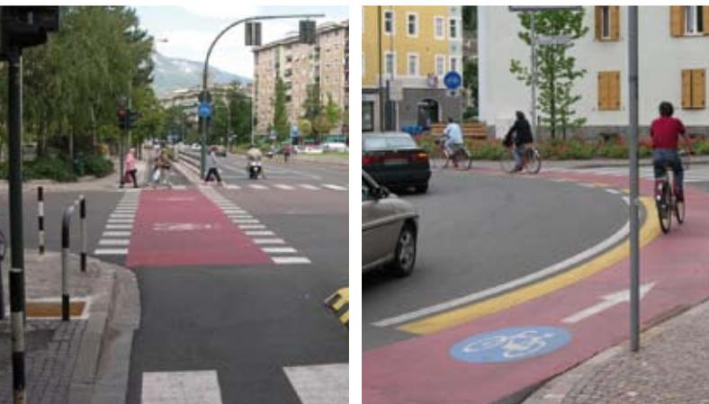
da sinistra: intersezione ciclabile semaforizzata ad alta visibilità intersezione a rotatoria con corsia ciclabile nell'anello
