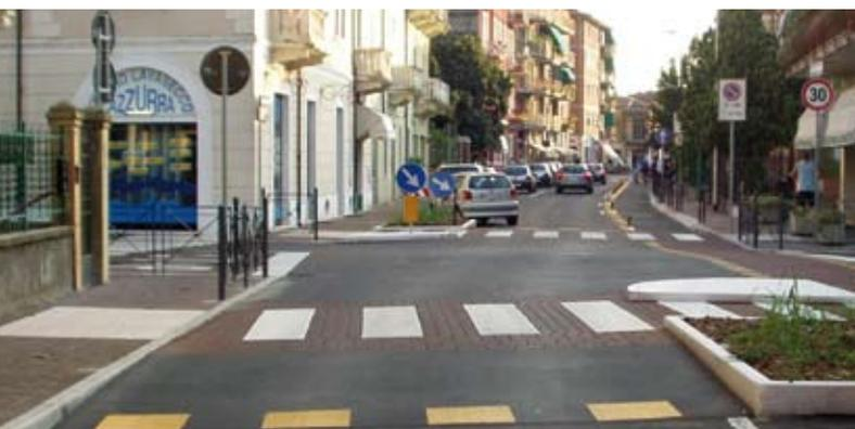
Chicane realizzata con alternanza della sosta e piattaforma in bitume
